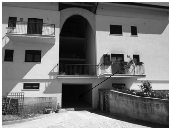
Foto 1 (ingresso comune garage)
